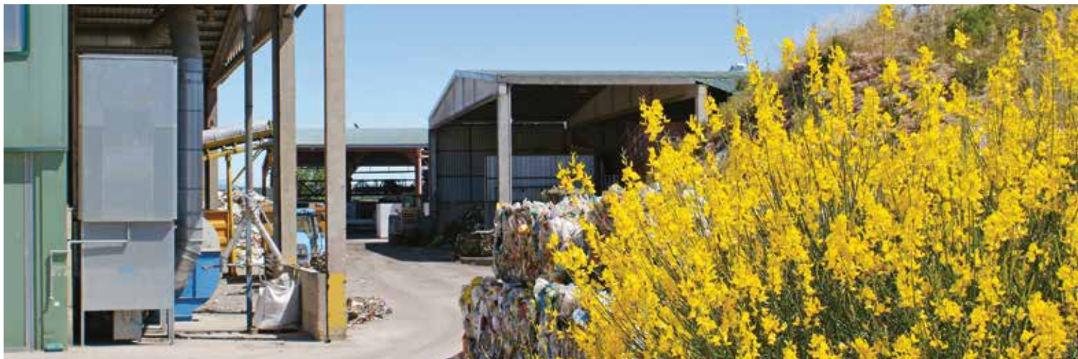
Nave de fracción resto y envases (izquierda), y nave de fracción orgánica.
