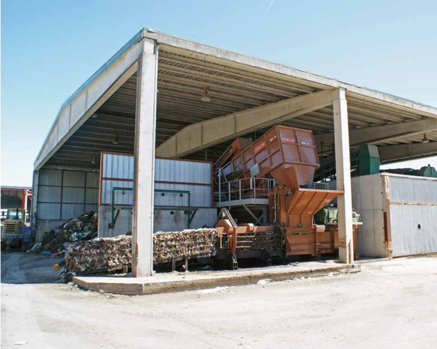
Prensa de rechazo de la materia orgánica en el centro de tratamiento de Cárcar.
